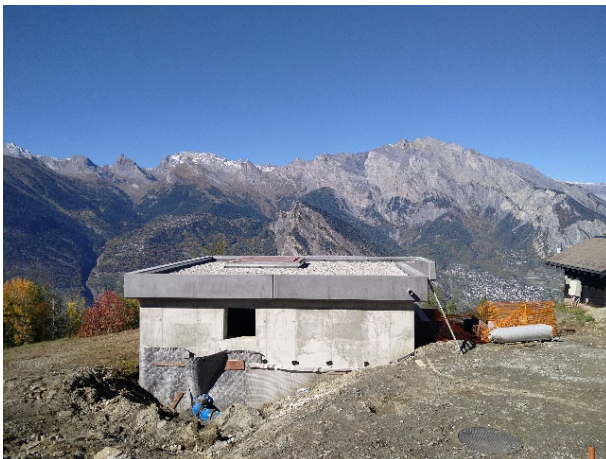
Bâtiment de turbinage «Les Combes» - Chantier 2022
