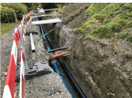
Fouille pour la pose de la conduite forcée et réfection du réseau d'eau potable Chantier 2019
