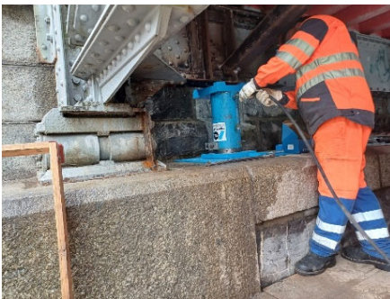
Préparation du vérinage
